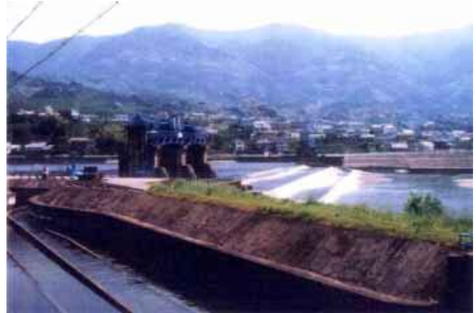
現在の藤崎井堰
