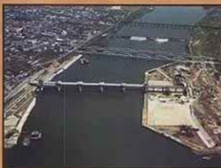
■ 4次縮切内でのP1・P2堰柱施工 (平成11年4月撮影)
