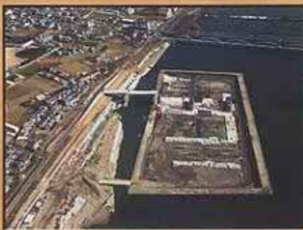
■ 2次縮切内でのP5・P6堰柱施工 (平成8年2月撮影)
