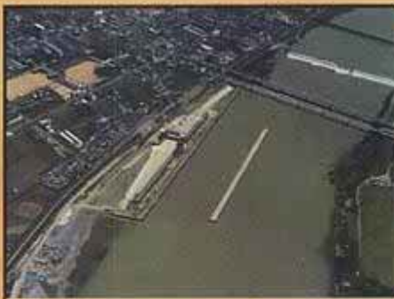
■ 1次縮切内でのP7・P8堰柱施工 (平成8年3月撮影)
