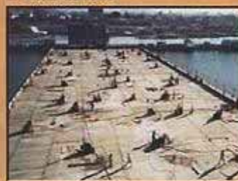
■ 薬液注入施工状況
