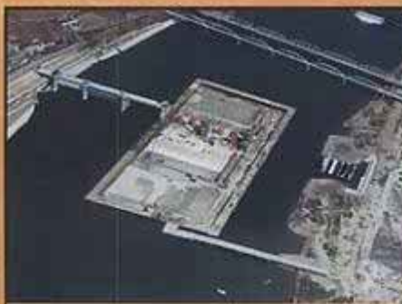
■ 3次縮切内でのP3・P4堰柱施工 (平成10年3月撮影)
