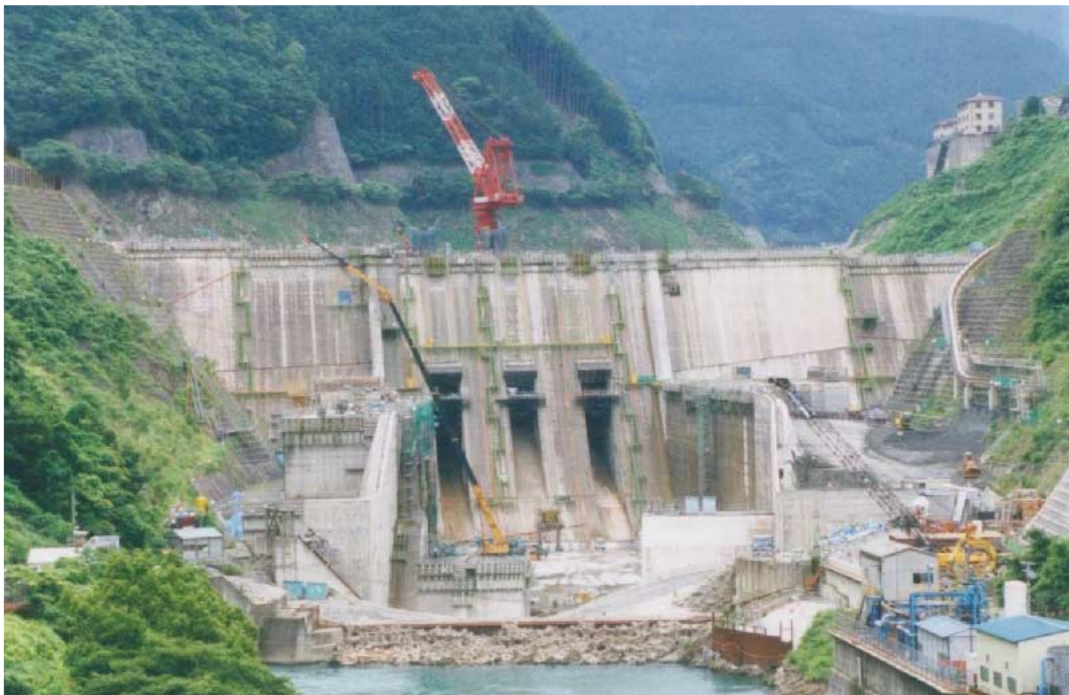
図9 大滝ダム本体工事
