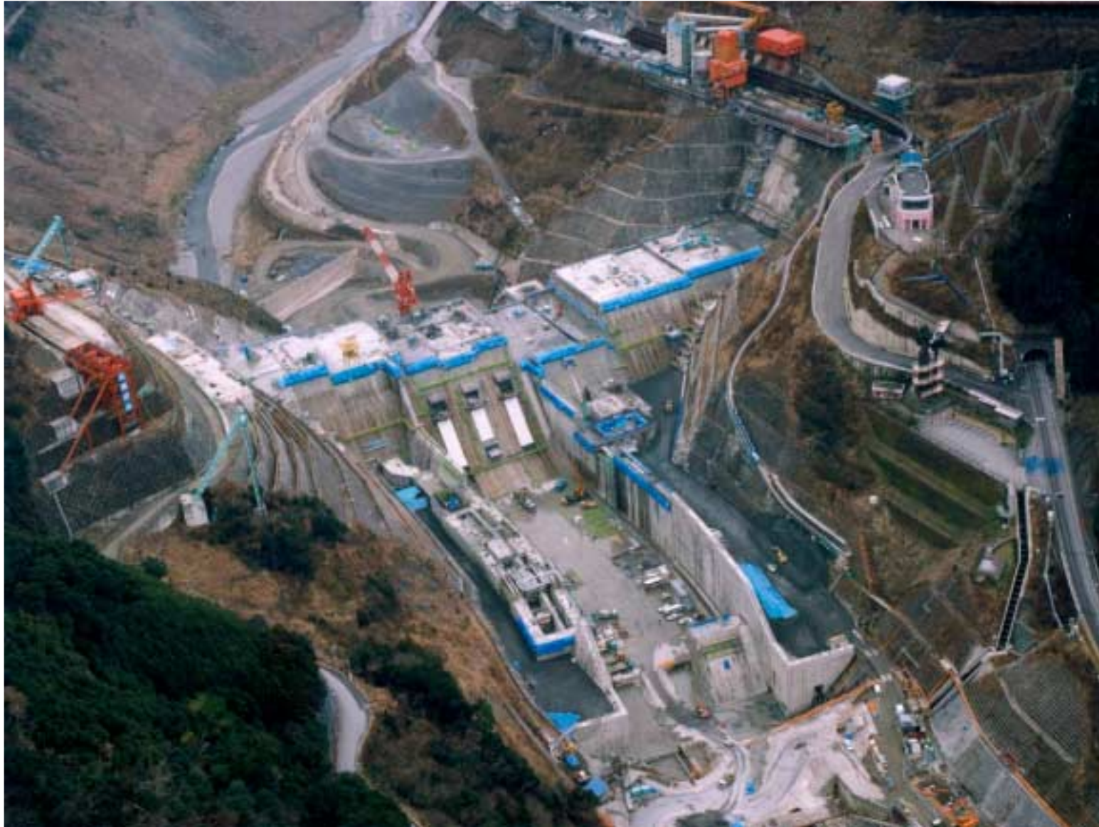
図10 建設中の大滝ダム本体工事航空写真 平成13年2月5日ダム本体下流上空より撮影 コンクリート約75万 m^3 打設時
