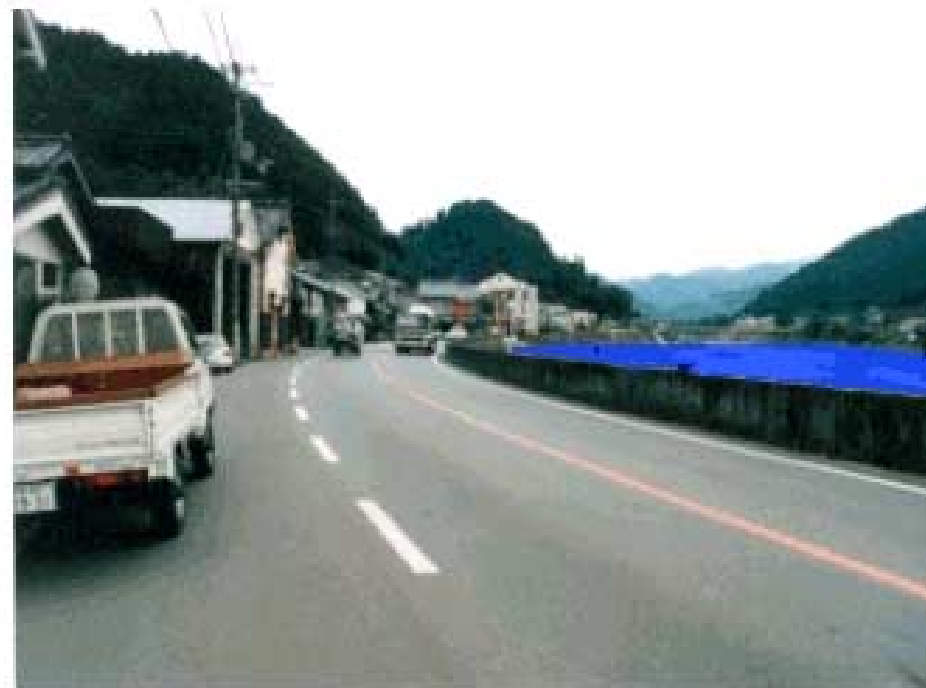
大滝ダムがある場合の水位 伊勢湾台風相当の洪水の場合
