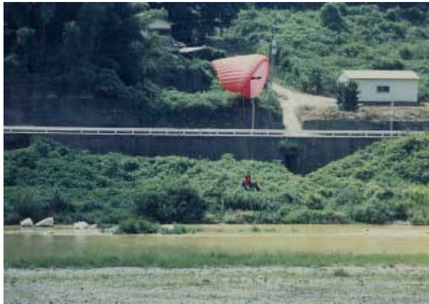
竹房橋付近（打田町）
