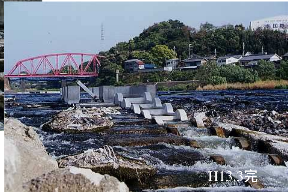
岩出橋 設置後
