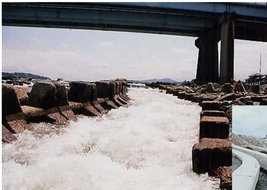
大川橋 改築前
