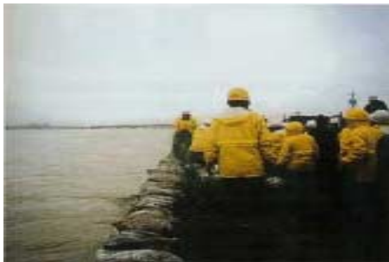
積み土のう工
