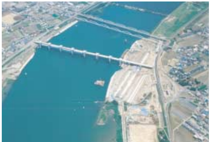
下流より紀の川大堰を望む
