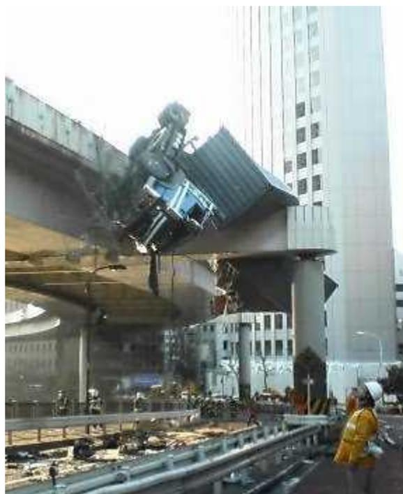
高欄を超え横転し、橋脚の横梁上に車両が落下。
