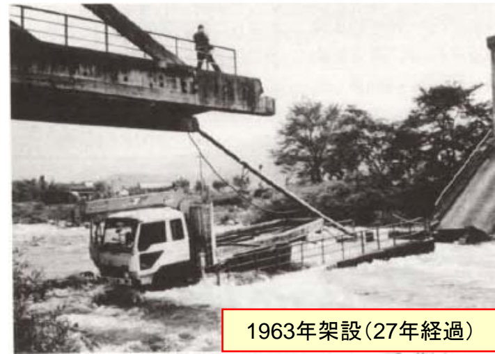
岐阜県福田町町道 島田橋 1990年 (腐食によるPCケーブルの破断)
