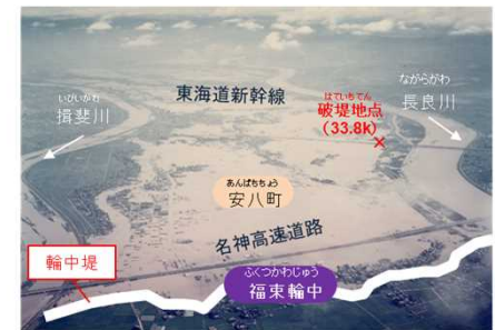
岐阜県輪之内町（福東輪中）
