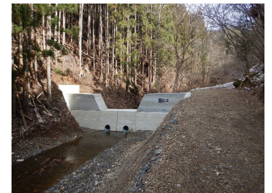
溪間工事の例
