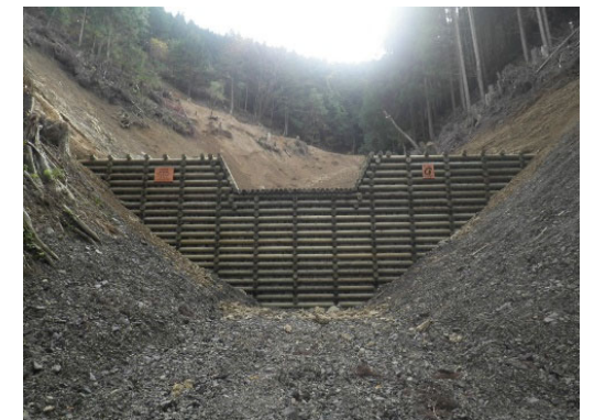
溪間工事の例
