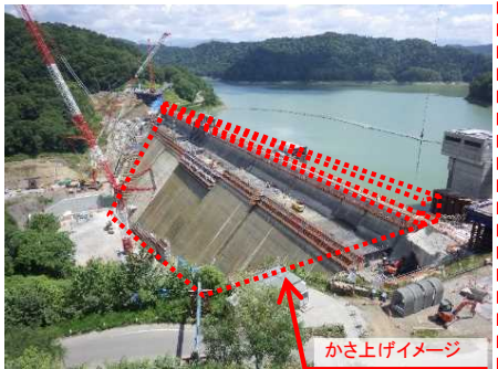
ダム建設・ダム再生
