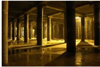
大規模地下貯留施設(下水道)
