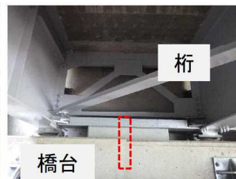
写真-5 アンカーバーのイメージ
