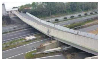
写真-1 県道小川嘉島線 府領第一橋
