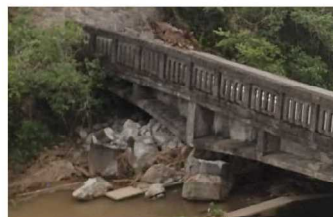
写真-2 平田・小柳線 田中橋
