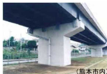
写真-3 国道3号 跨線部 (熊本市内)
