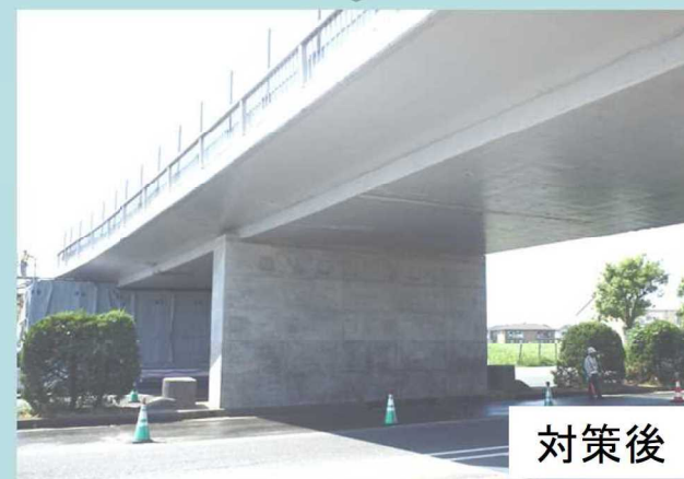
耐震補強の施工例
