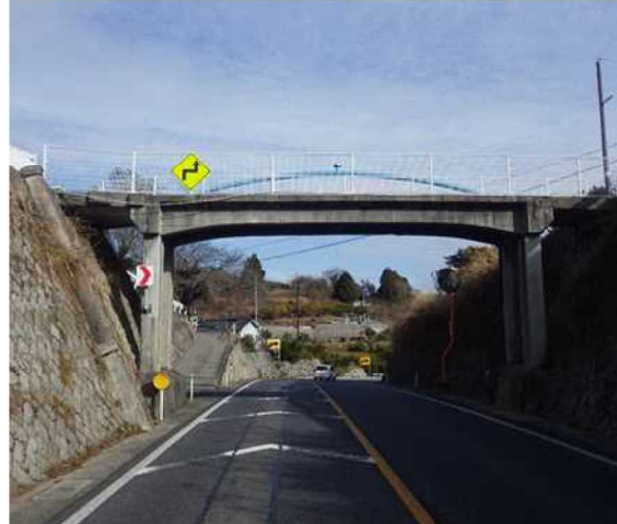
地方管理の跨道橋(未対策)
