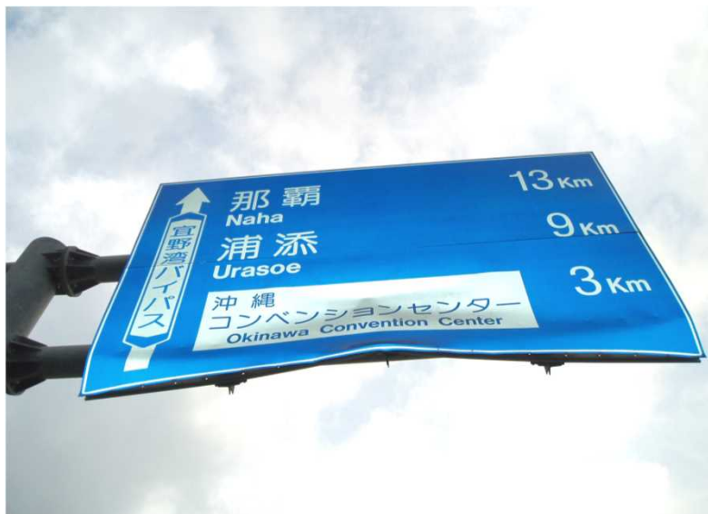
異常変形 (車両衝突)
