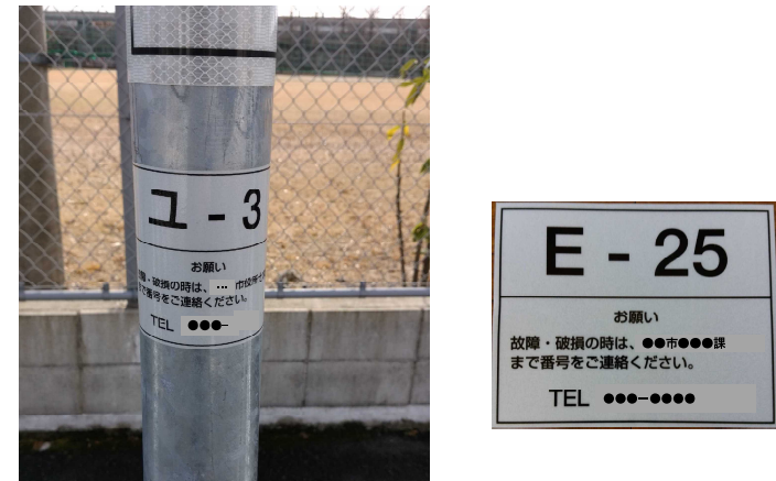
図-解 4-2 利用者から通報を受けやすく工夫している事例
