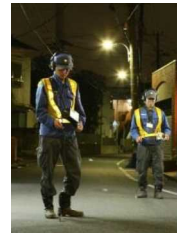
道路下の漏水調査
