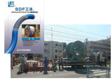
SDF工法の施工状況
