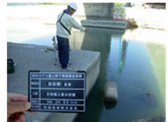
▲岩出橋 階段式魚道（撤去中）
