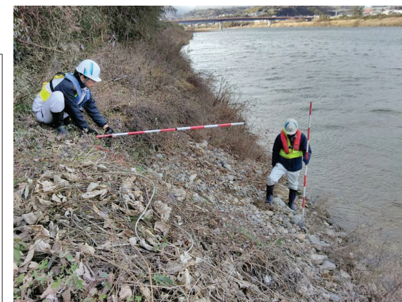
▲堤防点検の様子
