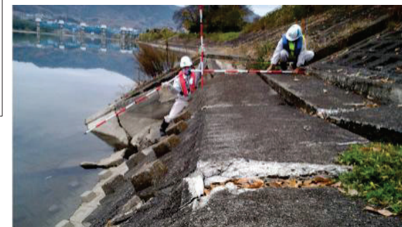
▲護岸点検の様子
