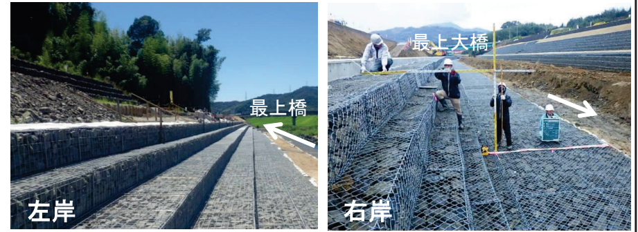
▲柘榴川の護岸施工状況
