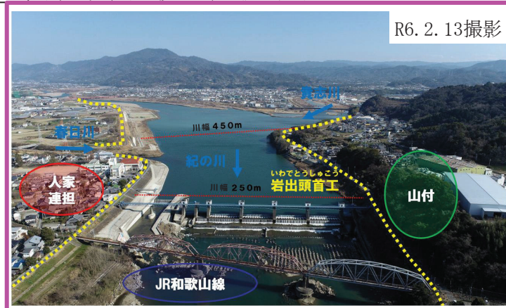
▲岩出狭窄部の状況
