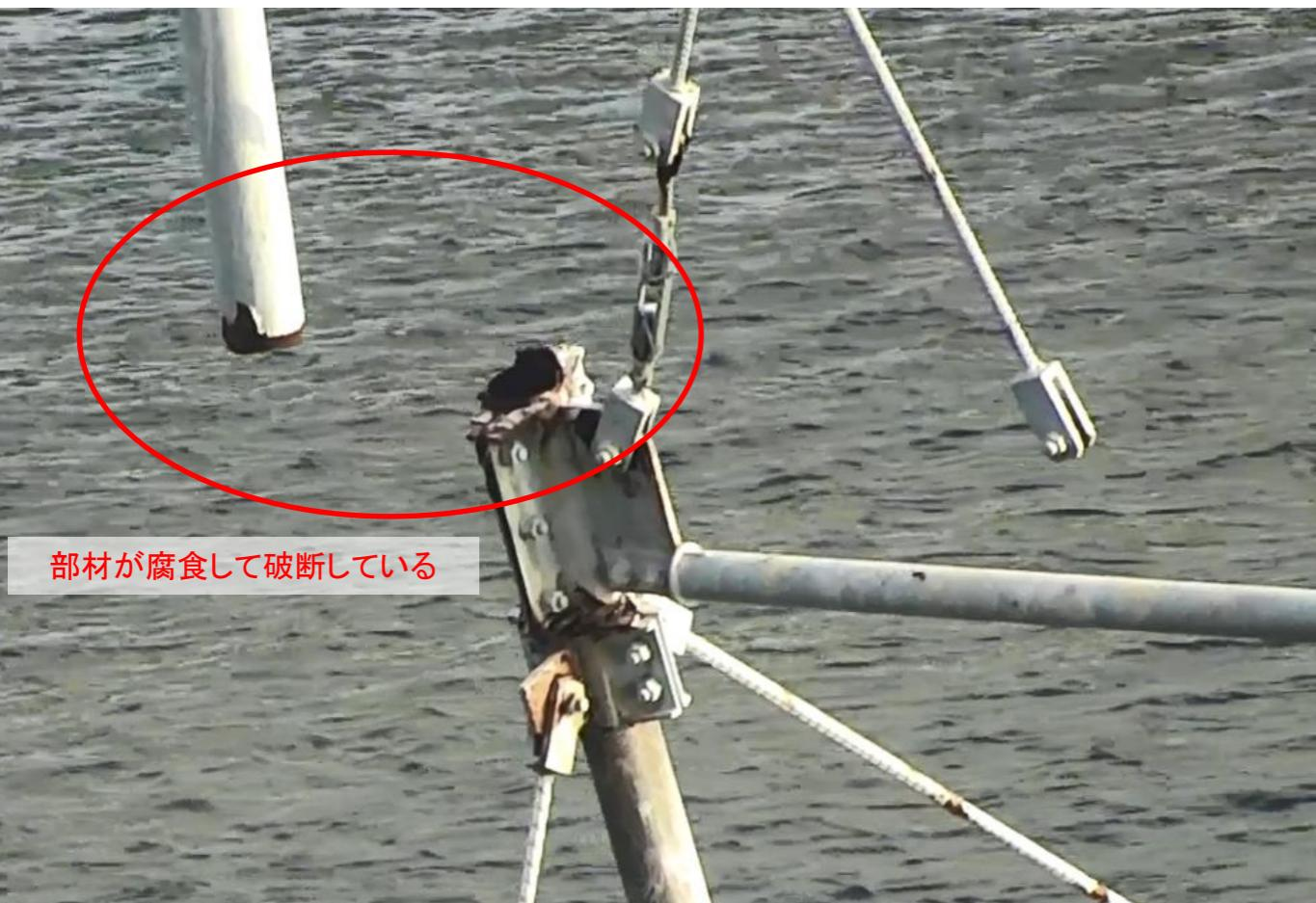
崩落した水管橋の部材破断面
