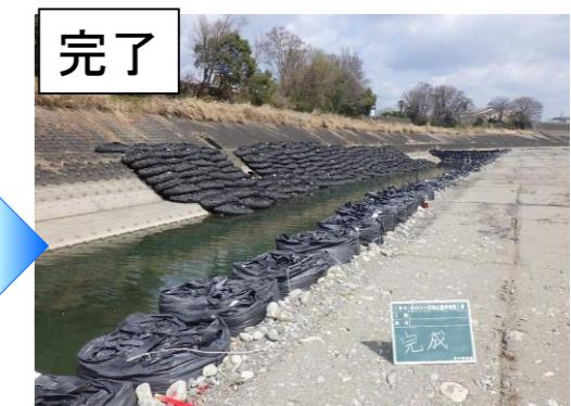
▲護岸応急復旧工事の状況 (R3年度、橋本市高野口町小田地区)
