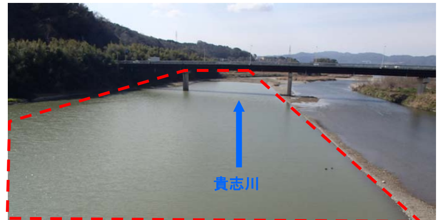
施工後（平成31年3月）
