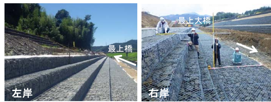
▲柘榴川の護岸施工状況
