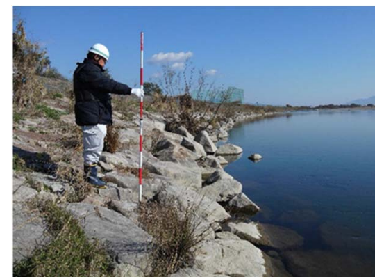
▲護岸点検の様子
