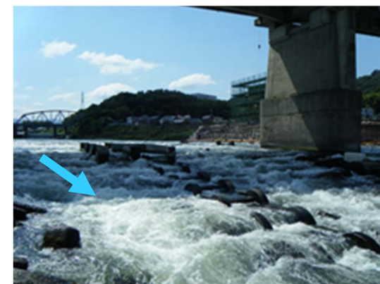
▲岩出橋 階段式魚道
