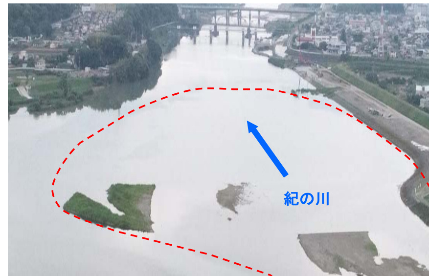
施工後（令和元年6月）
