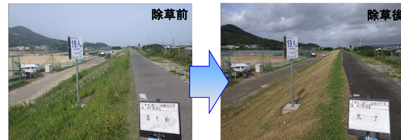
▲堤防除草作業の前後の状況(H30の状況)
