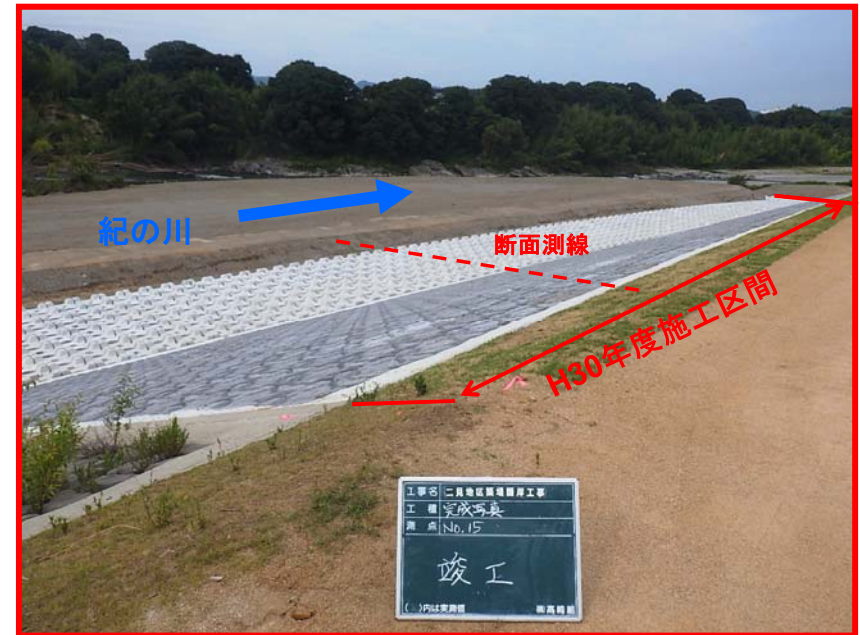
H30年度施工後
