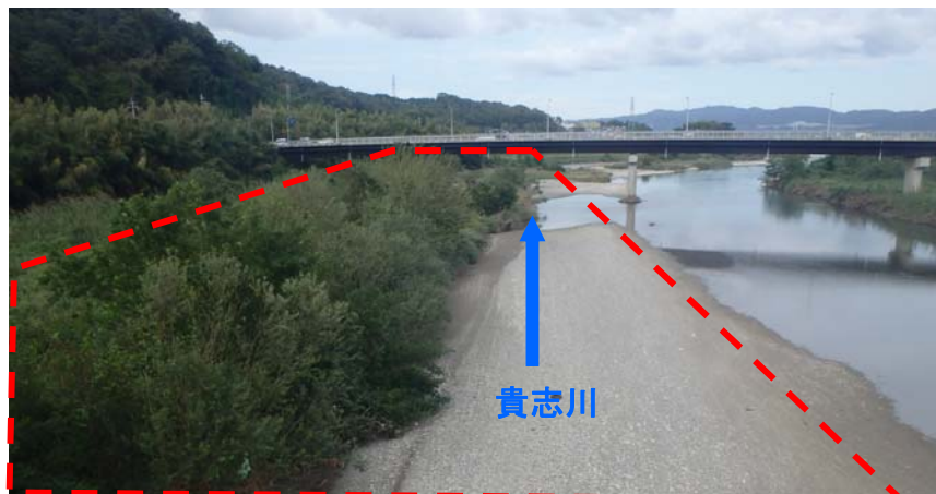
施工前（平成30年10月）
