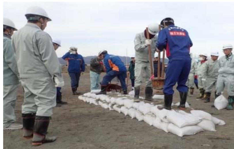
▲積み土のうの訓練
