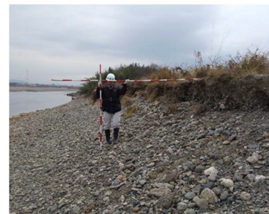
▲河岸点検の様子
