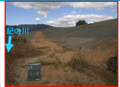
H30年度施工前
