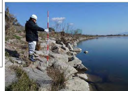
▲護岸点検の様子
