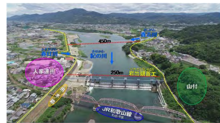
▲岩出狭窄部の状況
