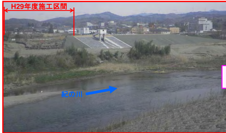
H29年度施工前
