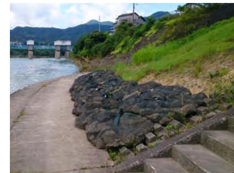
応急復旧実施状況
