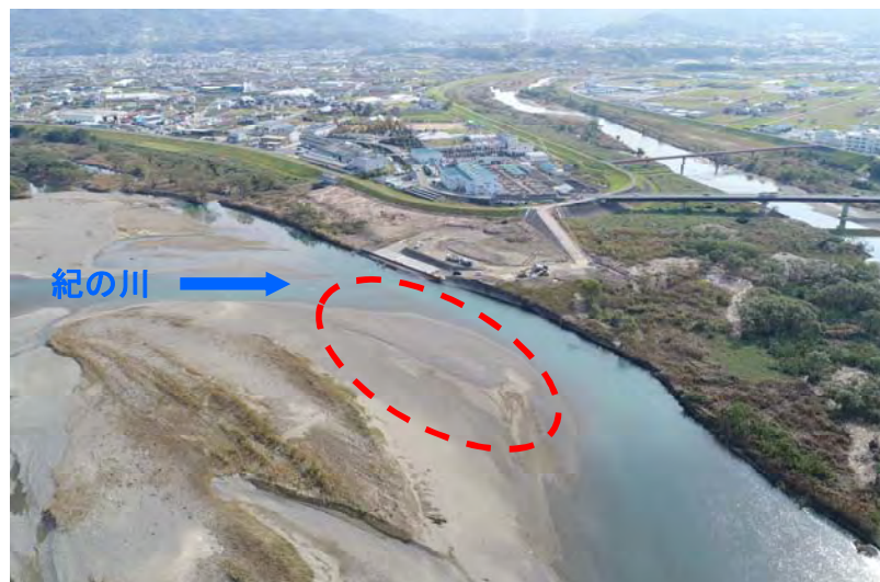
施工前(平成29年11月)
