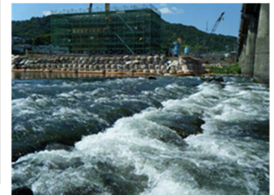
▲岩出橋 左岸護床工
