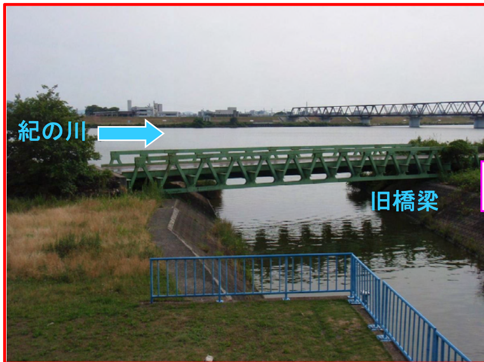
不破橋梁 施工前
