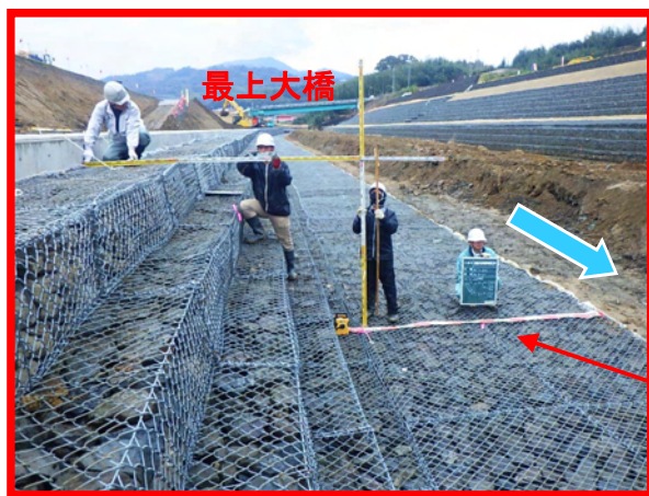
柘榴川右岸施工状況
