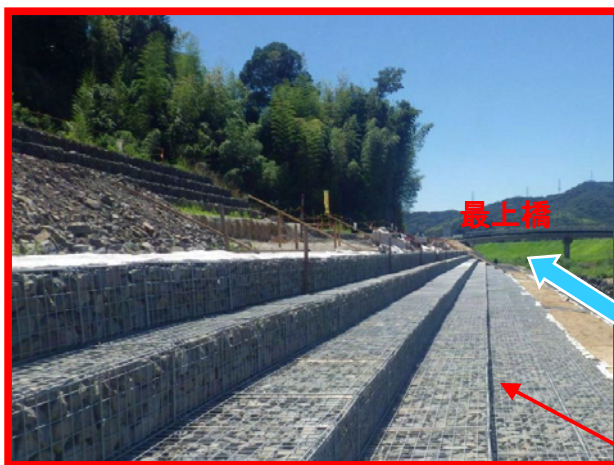
柘榴川左岸施工状況
