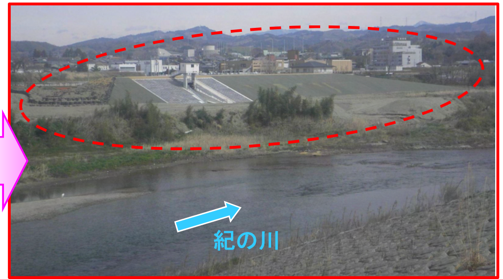
野原西地区施工後
