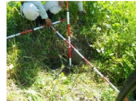
▲ 堤防点検の様子
