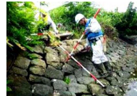
▲ 護岸点検の様子
