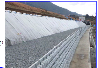
鋼製法枠 設置状況
