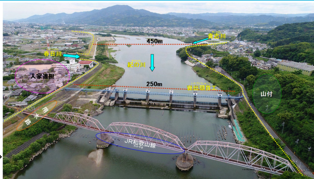
岩出狭窄部の現状⇒ (下流から上流方面を望む)
