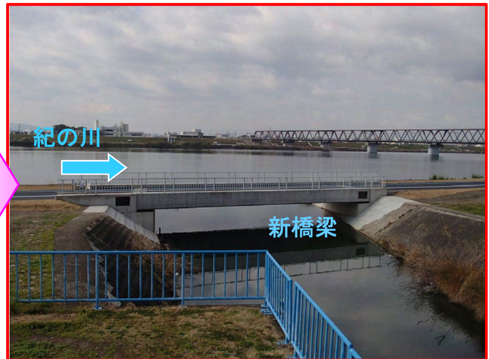
不破橋梁 施工後
