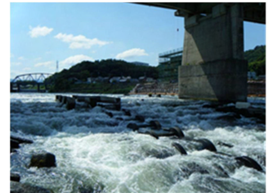
▲岩出橋 階段式魚道
