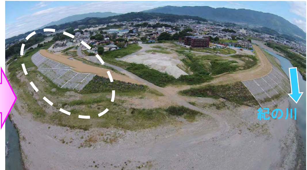
二見地区施工後
