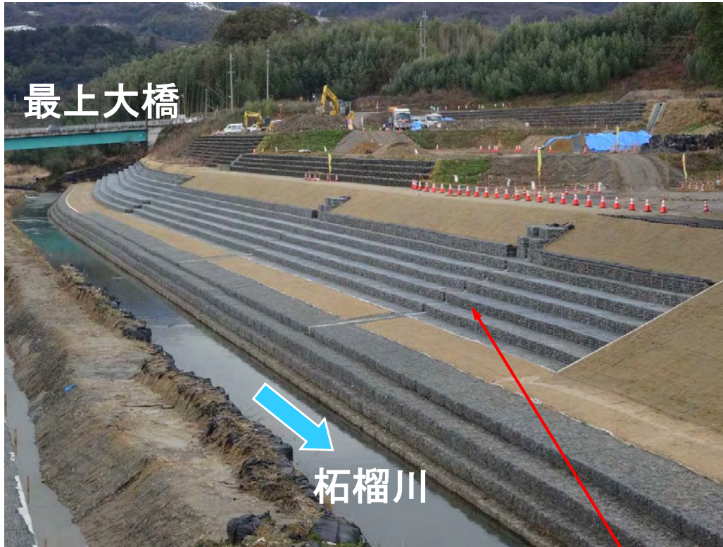
柘榴川施工状況
