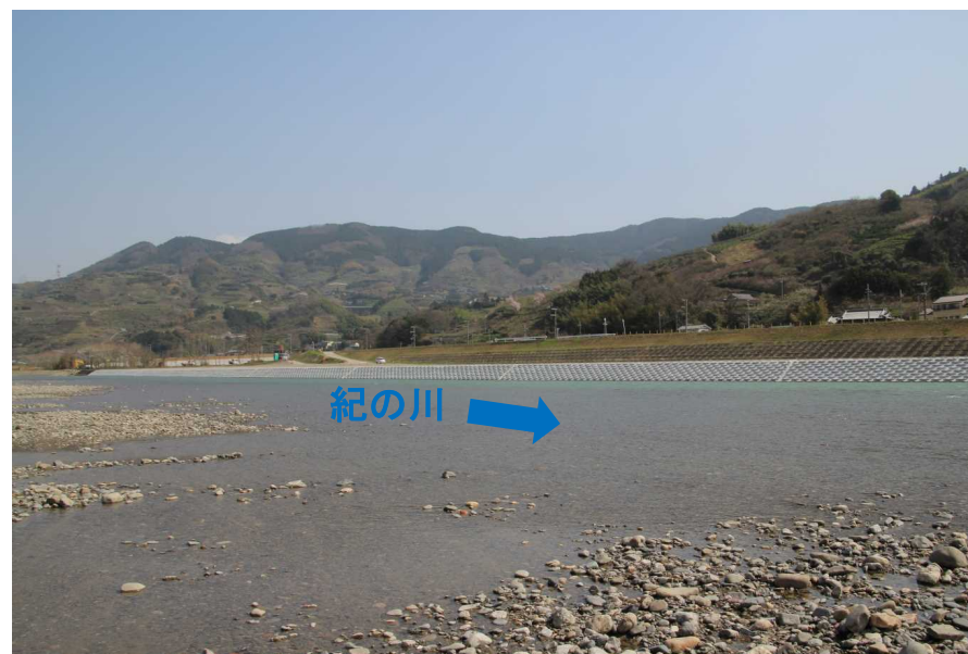
兄井地区完成状況(H27.4月)
