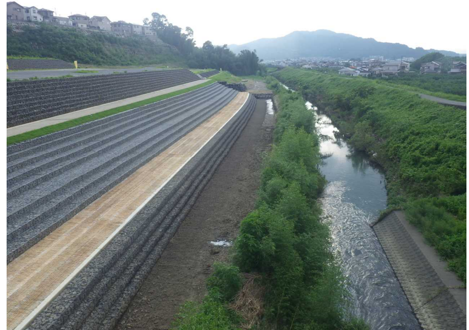
柘榴川施工状況(H27.7月)
