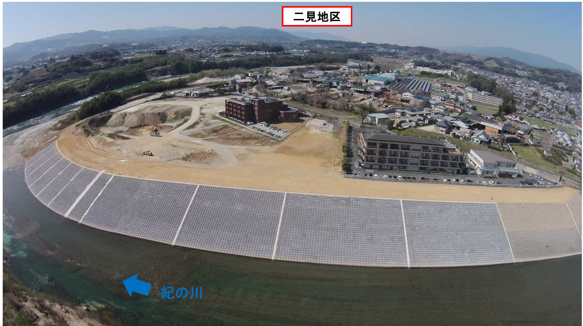
二見地区築堤状況
