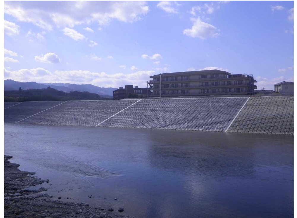
二見地区施工状況(H27.4月)
