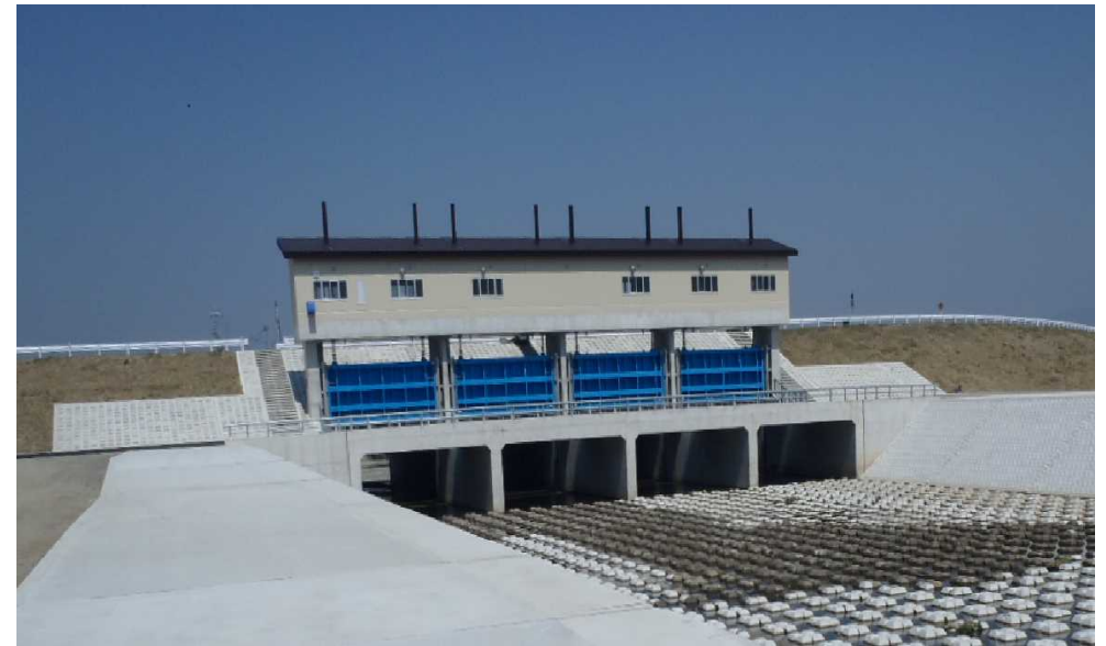
樋門完成状況 (H27.4月)
