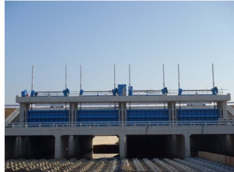
樋門施工状況(H27.1月末現在)
