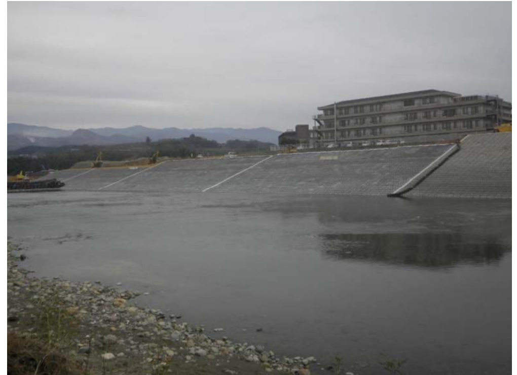
二見地区施工状況（H27.1月末現在）
