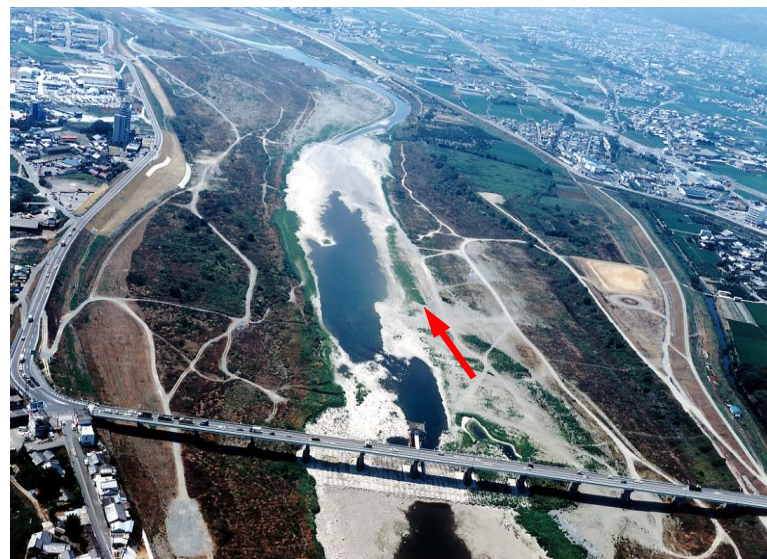
▲ 岩出橋付近の瀬切れ (平成6年8月)
