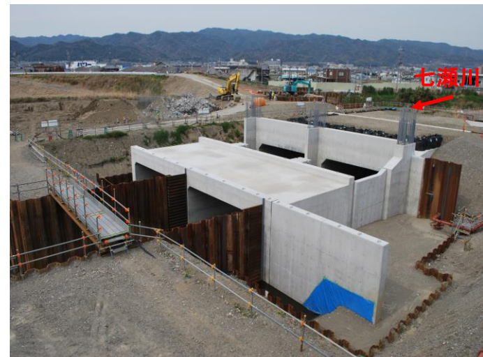
▲ 現在の七瀬川の工事状況
