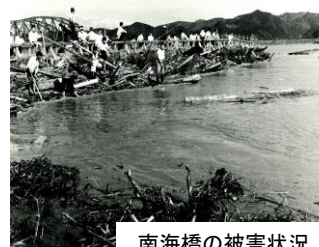
南海橋の被害状況
