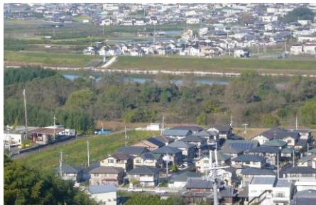
▲ 河道内樹木の状況
