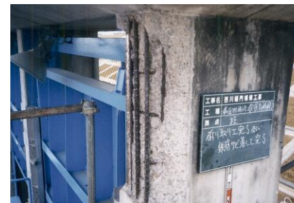
▲ 樋門の維持管理
