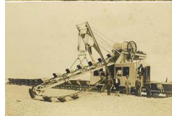
紀の川改修で活躍した建設機械 (掘削等に用いられたショベル(上)と ラダーエクスキャバータ(下)／昭和4～5年頃の撮影)
