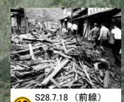
⑱ S28.7.18 (前線) 橋本市 被災状況 「写真:橋本市提供」
