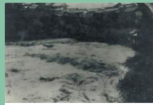
⑬ S28.7.18 (前線) 九度山町 丹生川の洪水状況 「写真:九度山町提供」
