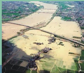
④ S57.8.2 (台風10号・台風9号から変わった低気圧) 和歌山市直川 浸水状況
