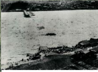
⑧ S28.7.18 (前線) 岩出市船戸付近 被災状況
