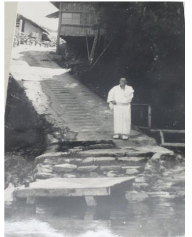
慈尊院と紀の川を結ぶ通路(船着き場)の写真
