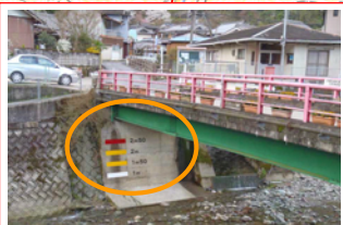
中古沢初花橋付近【不動谷川】 ①水位表示 (H25 町設置) ②カメラ (H26 町設置)
