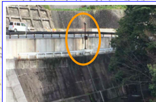
赤瀬橋付近【不動谷川】 ①水位計 (H30 県設置)
