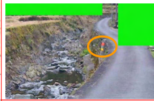
北又児童会館付近【北又川】 ①水位表示 (H29 県設置) ②カメラ (H27 町設置)
