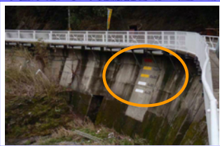
推出大橋付近【丹生川】 ①水位表示 (H25 町設置) ②カメラ (H30 県設置)
