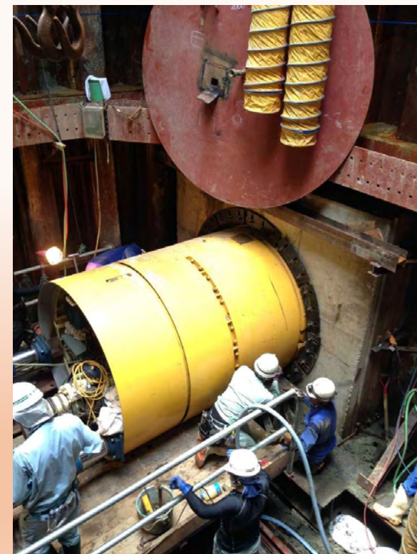
湊南第3排水区支線工事
