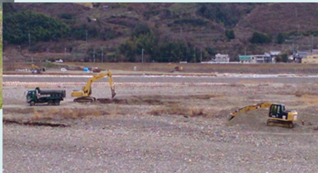
砂利採取業者による堆積土砂の除去
