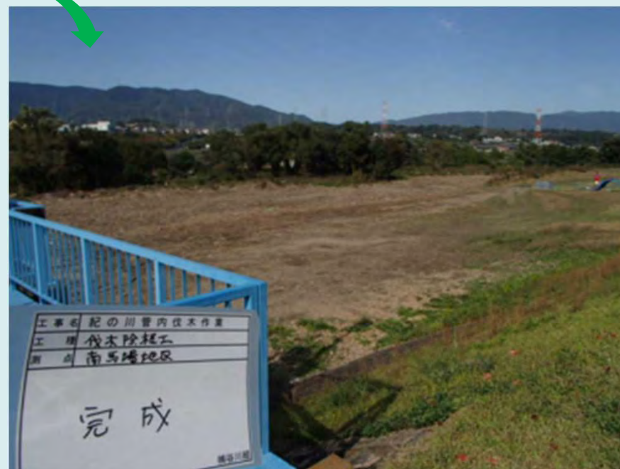
樹木伐採後の合流部
