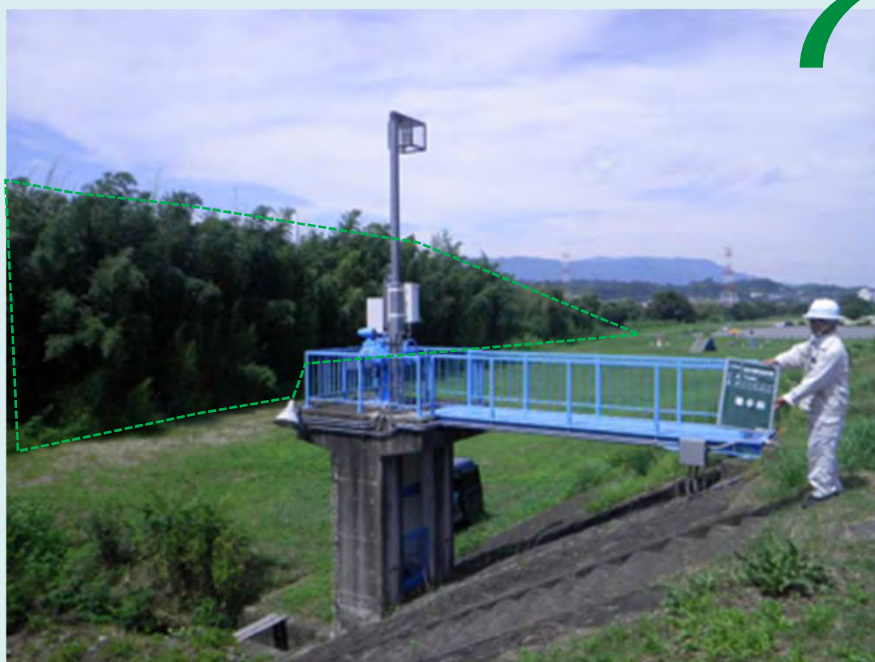
樹木伐採前の合流部
