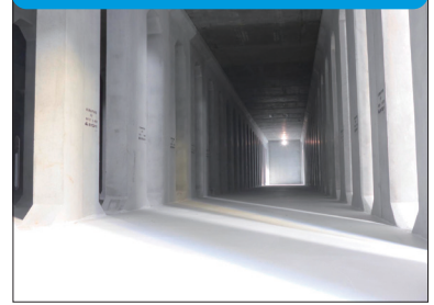
貯留型 (地下貯留槽)
