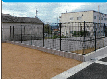
貯留型 (オープン式調整池)
