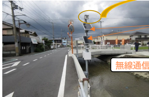
<簡易型河川監視カメラ>
