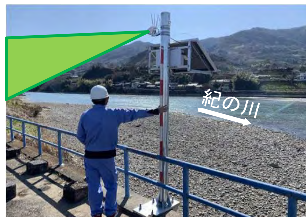
鋼管柱 (紀の川 藤崎頭首工)
