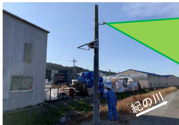
コンクリート柱 (紀の川 山崎)
