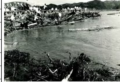
和歌山市南海橋の被害状況 (昭和34年伊勢湾台風)
