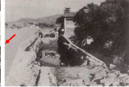
県道海南九度山線：麻生津(おうづ)～竜門間の被害状況(昭和28年台風13号)
