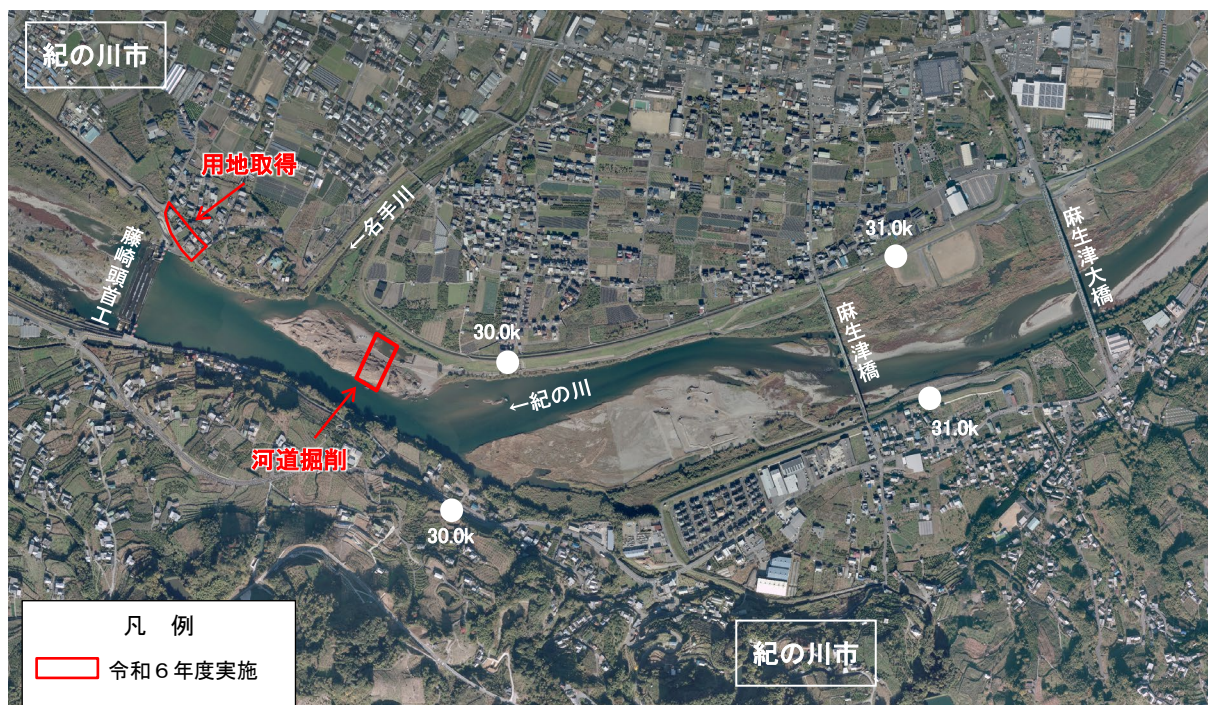
河道掘削（藤崎地区）
