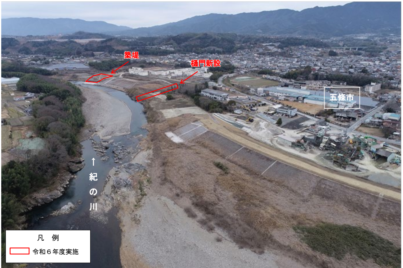
築堤（二見地区）
