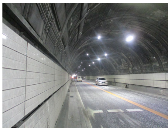
塩津第一トンネル
