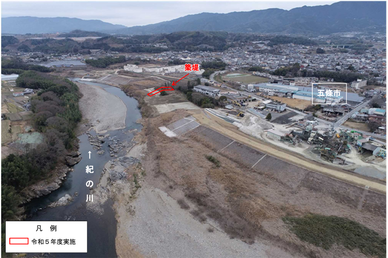
無堤部解消（二見地区）
