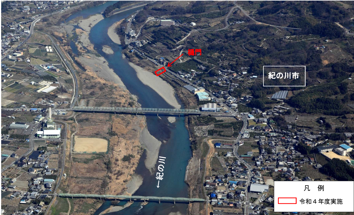
無堤部解消（麻生津地区）
