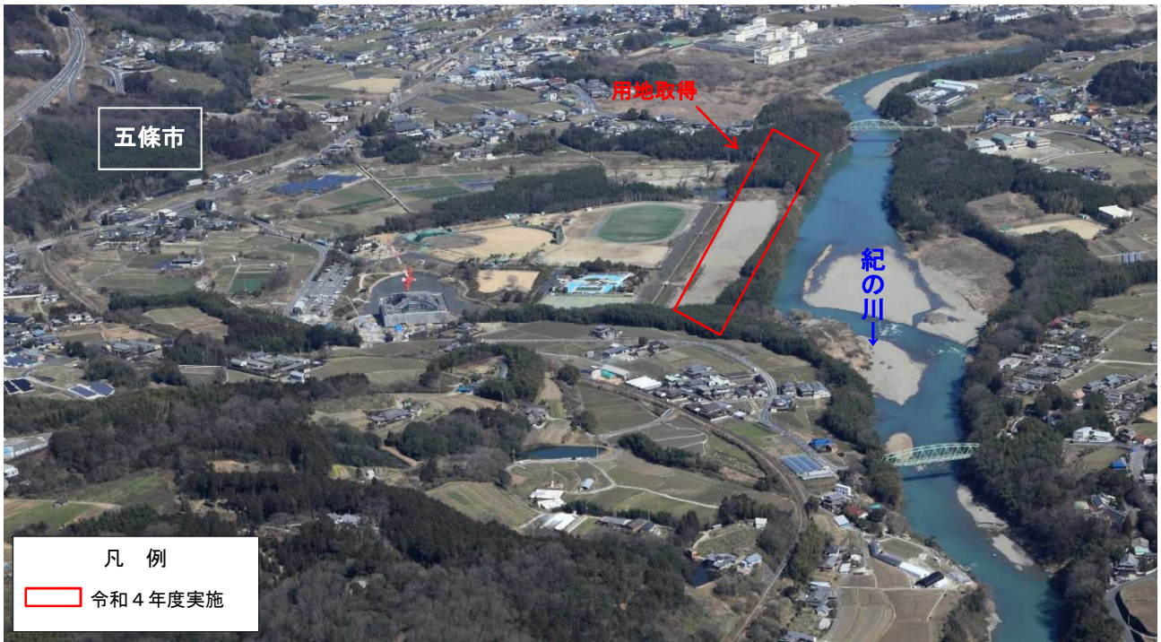
無堤部解消（上野地区）
