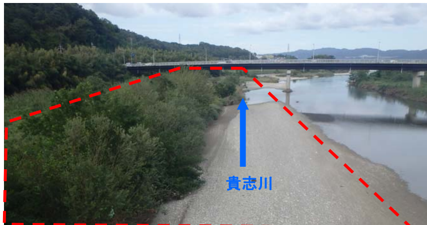
施工前（平成30年10月）
