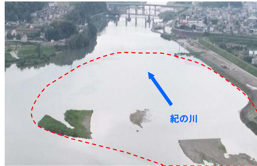
施工後（令和元年6月）
