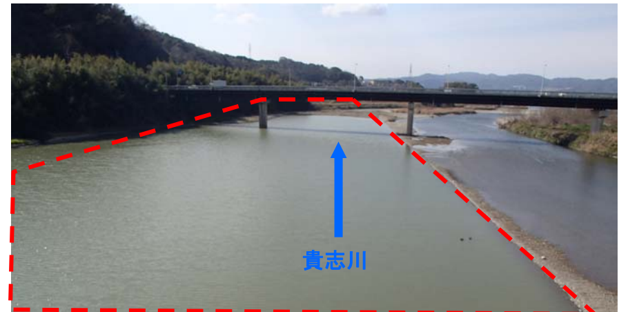
施工後（平成31年3月）
