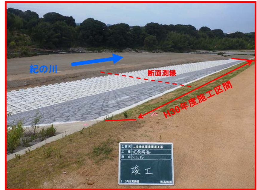
H30年度施工後
