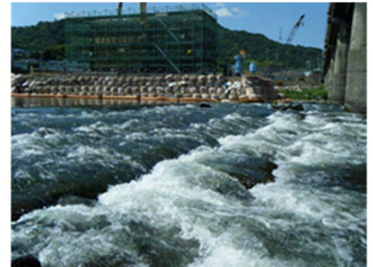
▲岩出橋 左岸護床工
