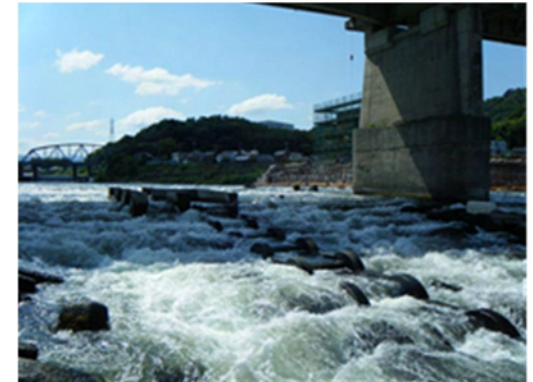
▲岩出橋 階段式魚道
