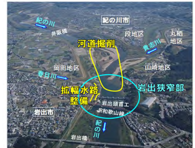
▲ 岩出狭窄部の状況
