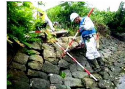
▲ 護岸点検の様子
