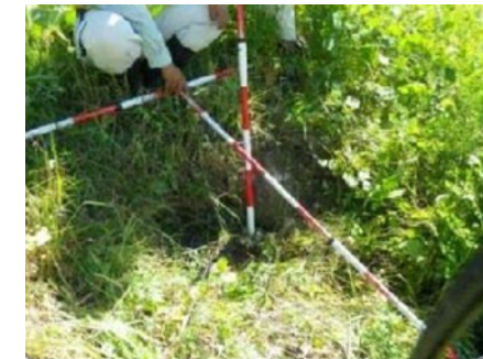
▲ 堤防点検の様子
