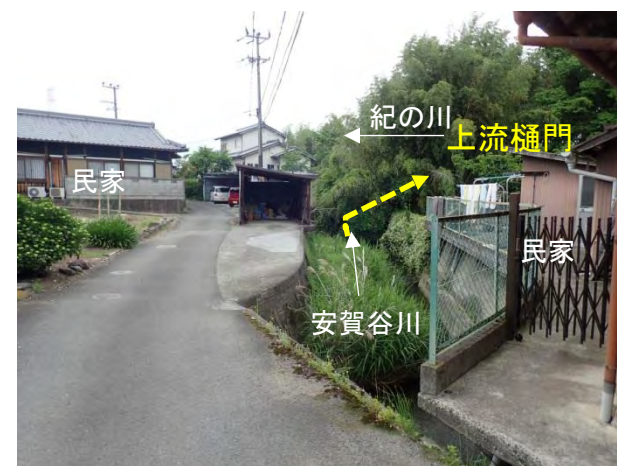
① 上流樋門設置位置の景観
