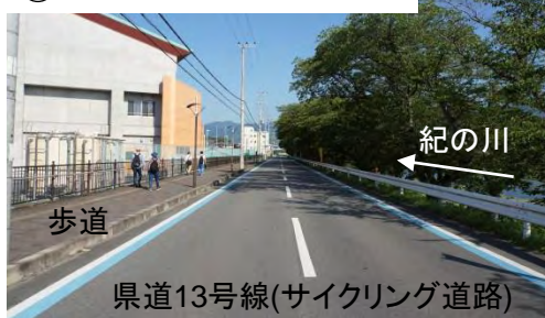
⑤道の駅～計画堤防上流端
