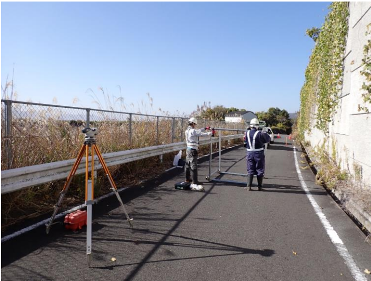
ボーリング調査
