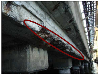
コンクリートの剥離、鉄筋腐食が発生
