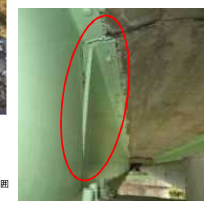
主桁の変形
