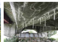
主桁のひびわれ
