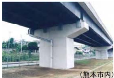
写真-3 国道3号 跨線部 (熊本市内)
