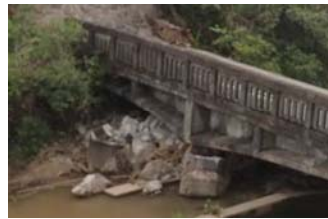
写真-2 平田・小柳線 田中橋
