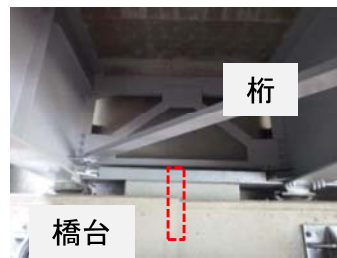
写真-5 アンカーバーのイメージ
