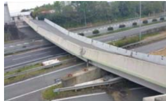
写真-1 県道小川嘉島線 府領第一橋
