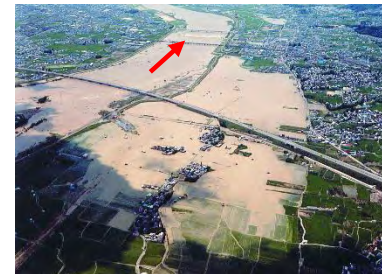
和歌山市直川(のうがわ)地区の浸水状況(昭和57年台風10号及び台風9号からかわった低気圧)
