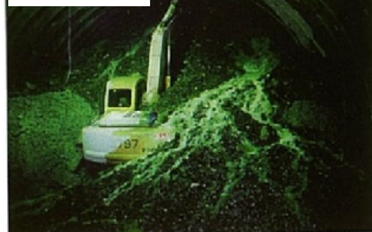
掘削時の湧水
