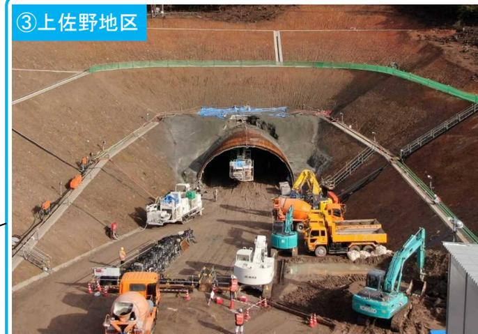
佐野トンネルの掘削を1月中旬から開始しました。上佐野から戸牧(南から北)に向かって掘削し、現在坑口から約5m付近まで掘削が進んでいます。今後も安全に配慮しながら工事を進めていきます。
