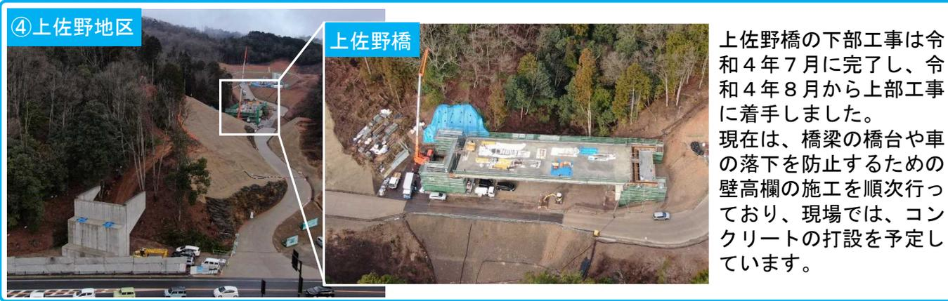
上佐野橋の下部工事は令和4年7月に完了し、令和4年8月から上部工事に着手しました。現在は、橋梁の橋台や車の落下を防止するための壁高欄の施工を順次行っており、現場では、コンクリートの打設を予定しています。
