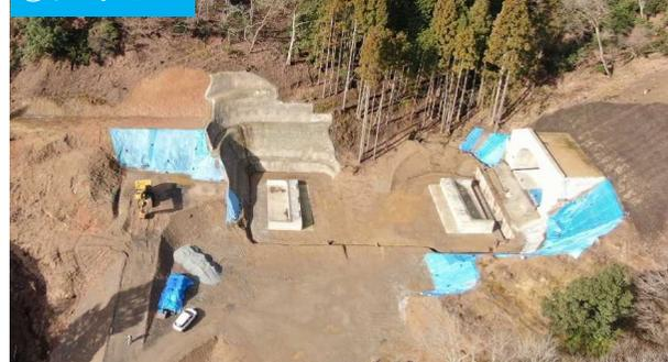
佐野橋の下部工事は令和4年11月に工事が完了しました。今後、上部工の施工を進めてまいります。
