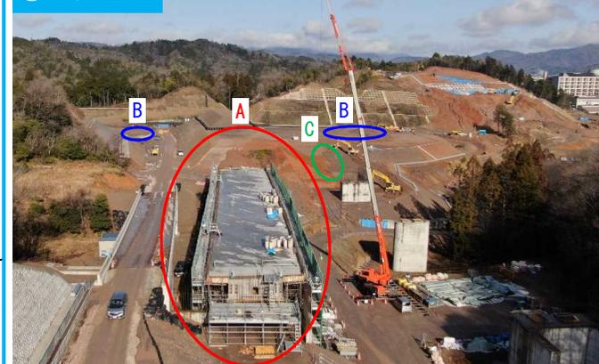
細見川橋(A)の上部工の施工を行っております。現在は、支保工、型枠解体を行っており、今後は車の落下を防止するための壁高欄の施工を進めてまいります。また、北側ではチェーン脱着場(B)の掘削や路体盛土(C)の施工を行っております。
