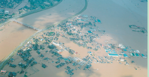
台風23号の被災状況(H16.10)
