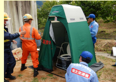
仮設トイレ完成
