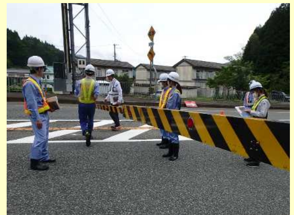
電動操作盤による遮断機の操作
